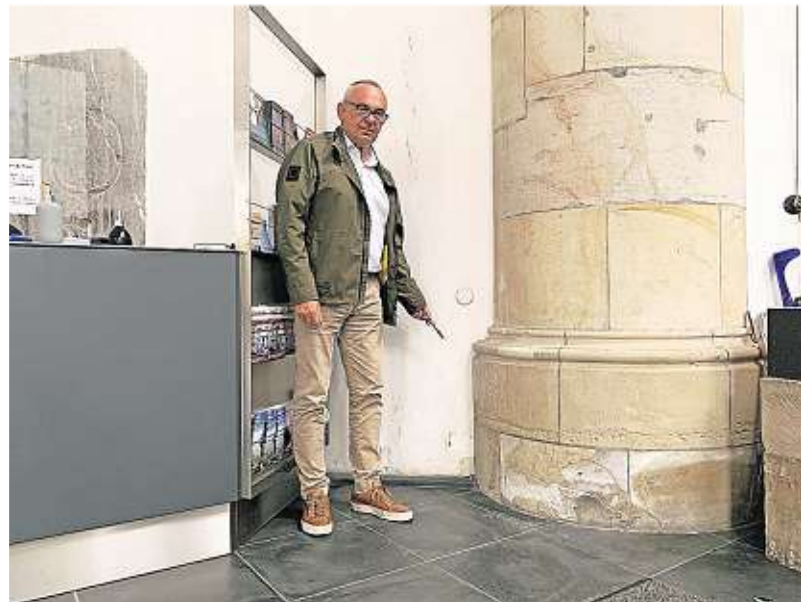
Dieter Rudolph vom Dombauverein zeigt auf eine Stelle, wo Strom von außen elegant in die Kirche hereingeholt werden kann.
